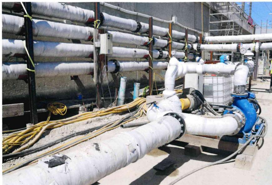
Verbindungsleitungen der Kälteaggregate zu den Vortrieben.
