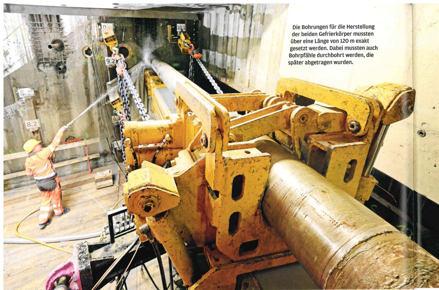
Die Bohrungen für die Herstellung der beiden Gefrierkörper mussten über eine Länge von 120 m exakt gesetzt werden. Dabei mussten auch Bohrpfähle durchbohrt werden, die später abgetragen wurden.
